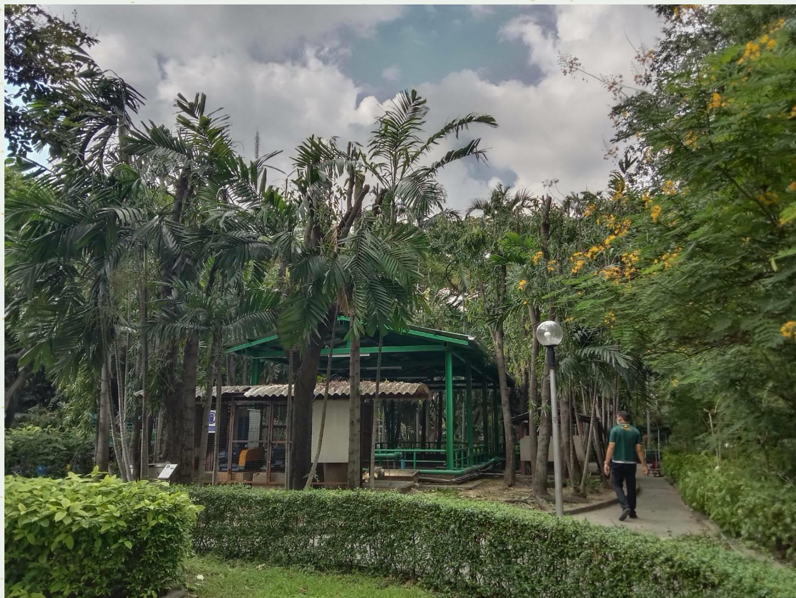
บ่อบำบัดน้ำเสีย
