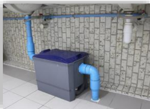
ชั้น 1 บริเวณห้องפקฝั่งหนังสือชั้นปิด
